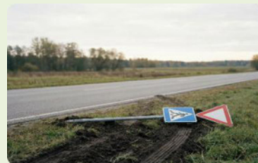
Imaginea 8: Indicatoare rutiere deteriorate
