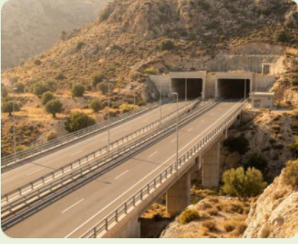
Resim 14 Viyadük ve tünel
